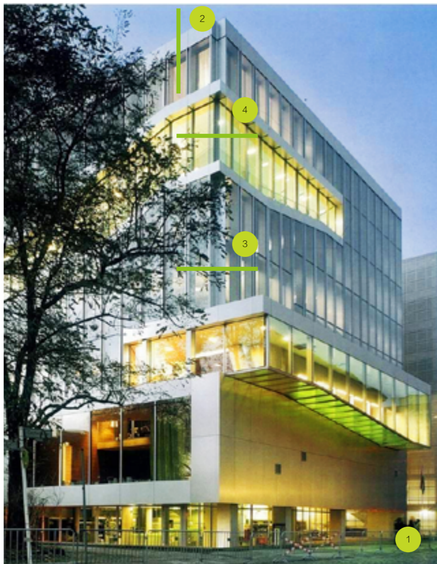
三层钢化玻璃 + 带不锈钢金属网空腔 + 充氮空腔
